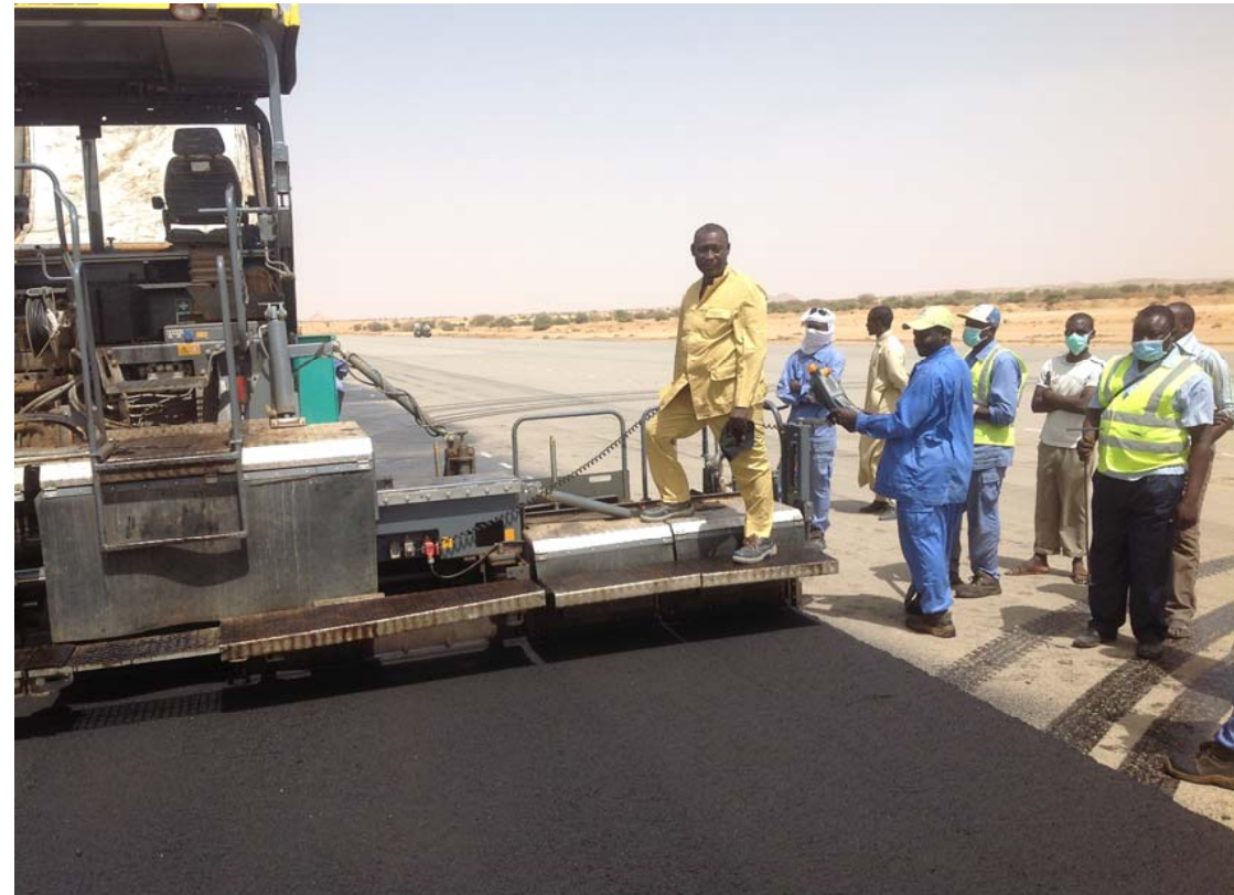
Aéroport international d'Amdjarass, capable d'accueillir les appareils de type Boeing 747. Le contrôle des travaux a été assuré par AGRITCHAD S.A.
